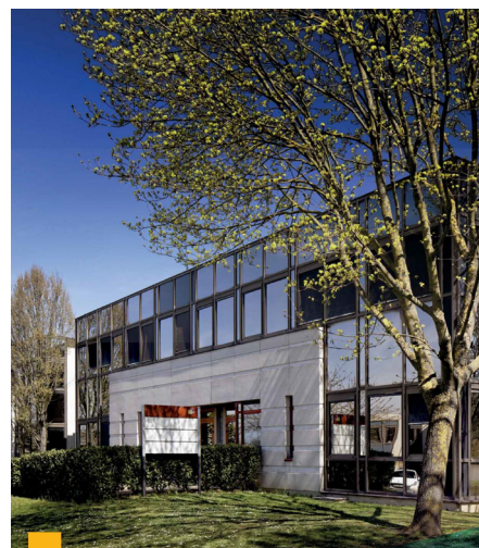
29, rue Le Corbusier à Créteil (94)
